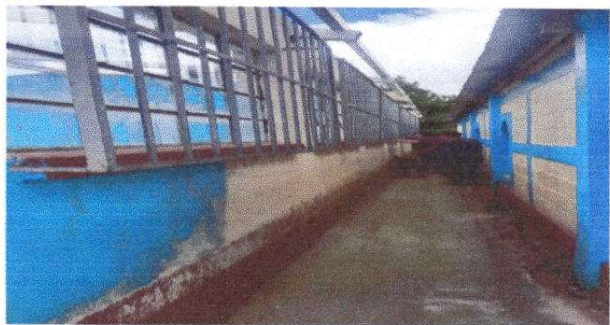
Foto 4: Pintura en muros exteriores e interiores
