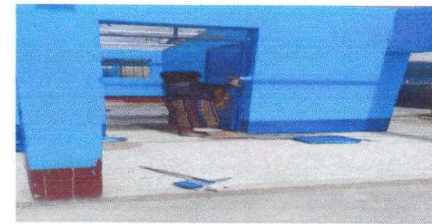
Foto 5: Pintura en muros exteriores e interiores
